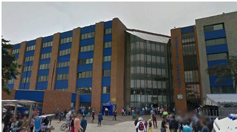
Fotografía 5.1.5-4 Hospital de Kennedy
